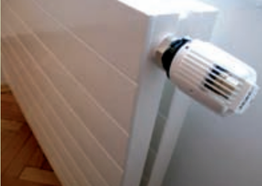
Heizkörper mit Thermostat
